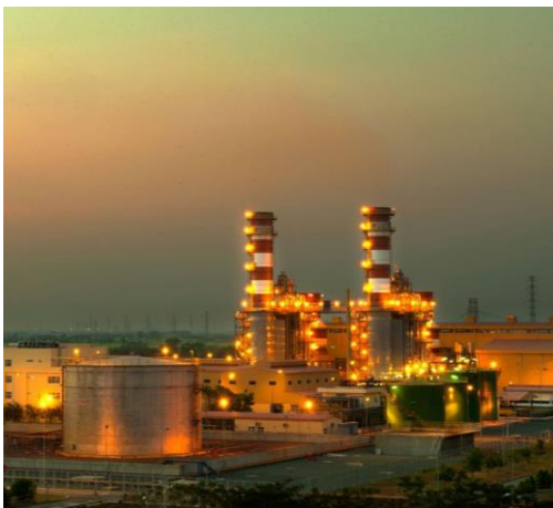
Nhà máy nhiệt điện khí đã vận hành của PVPower
