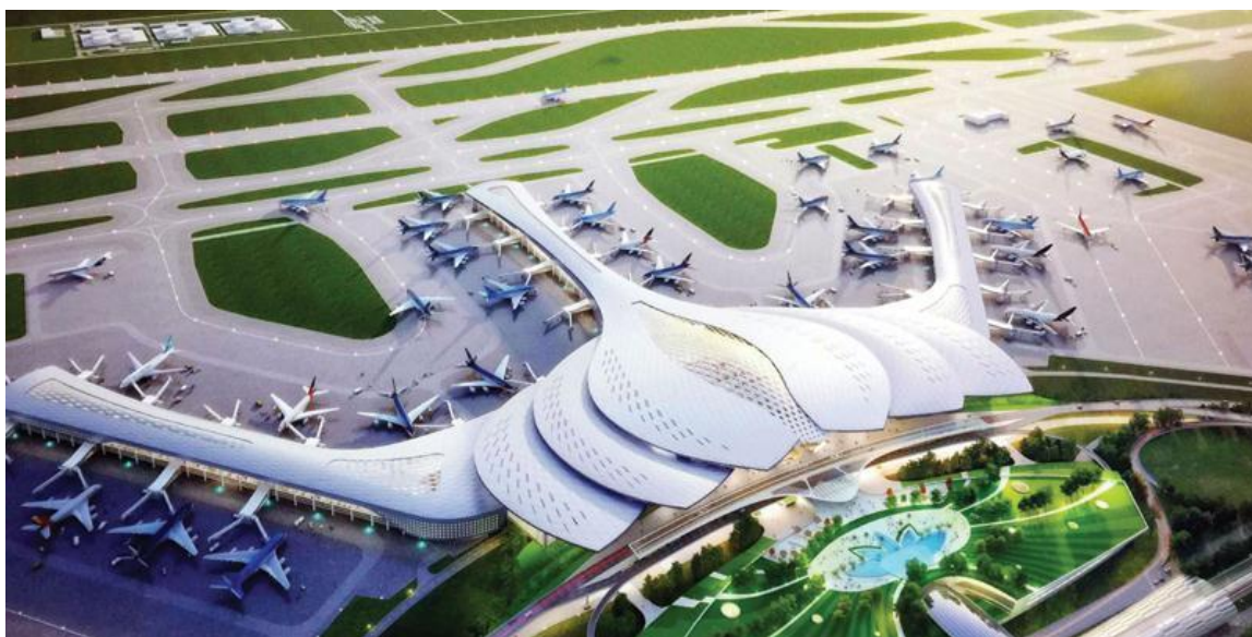
Toàn cảnh dự án Cảng hàng không quốc tế Long Thành sau khi hoàn thành
